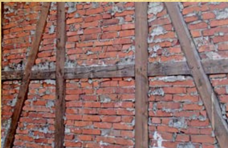
▲ Mur pruski: czyli drewniany szkielet i wypalona cegła
