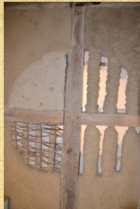
Różne techniki tworzenia ścian z drewna i gliny niewypalanej
