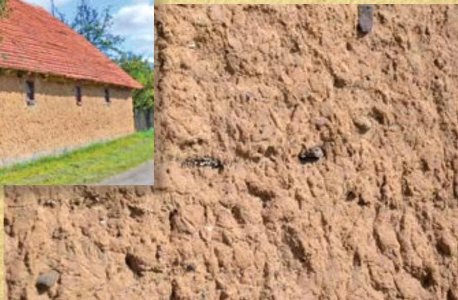
▲ Ściana w technice kładzionej
